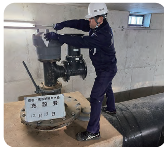
定期的な空気弁の清掃
