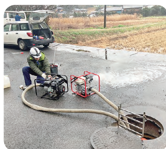
東部幹線施設排水作業
